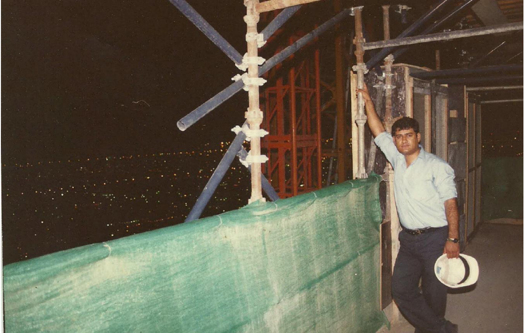
SCC pour for transfer beam, Shangri-La Hotel in Dubai - 2002
