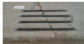
Dowel Bar Retrofit
